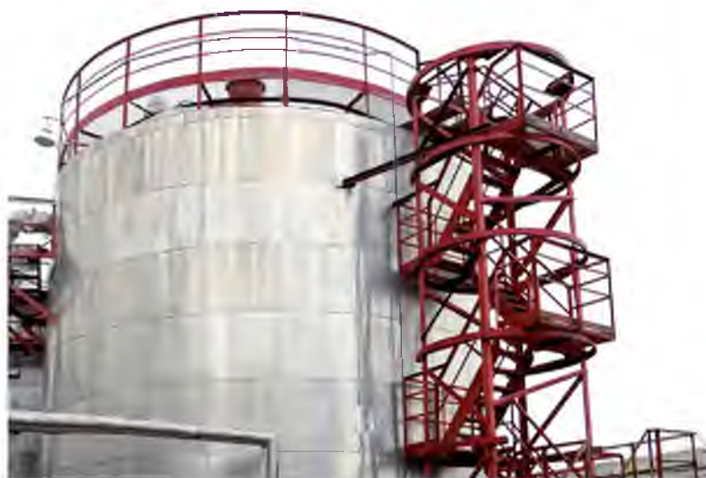
Цех №16, склад кислоты – один из объектов, обновление которого курировала Мария Демченко. Для ёмкости сделали новое бетонное основание и выложили поверхность кислотоупорным кирпичом. Планируется, что новая химзащита прослужит не менее 20 лет
